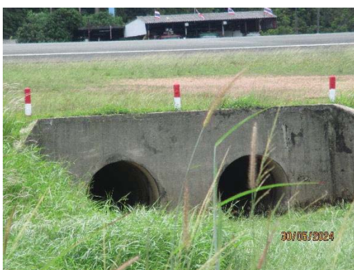
ภาพถ่ายที่ 2.2-9 ท่อระบายน้ำแบบหน้าตัดวงกลม
